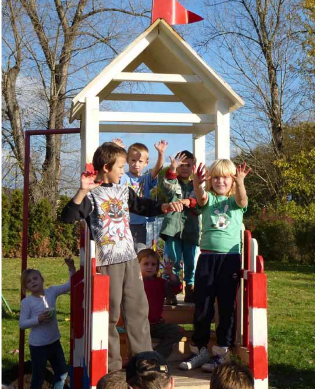
Oprava dětského hřiště v centru obce Křešice, poničeného povodní v roce 2013. Kvůli havarijnímu stavu a nedostatku prostředků provozovatele hrozilo jeho zrušení. Foto: archiv Ústecké komunitní nadace
